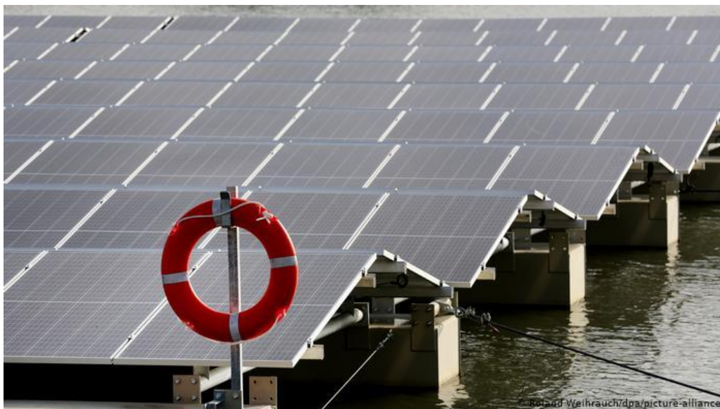
Так вблизи выглядит плавучая солнечная электростанция в Веце: 90 понтонов и 2000 панелей
