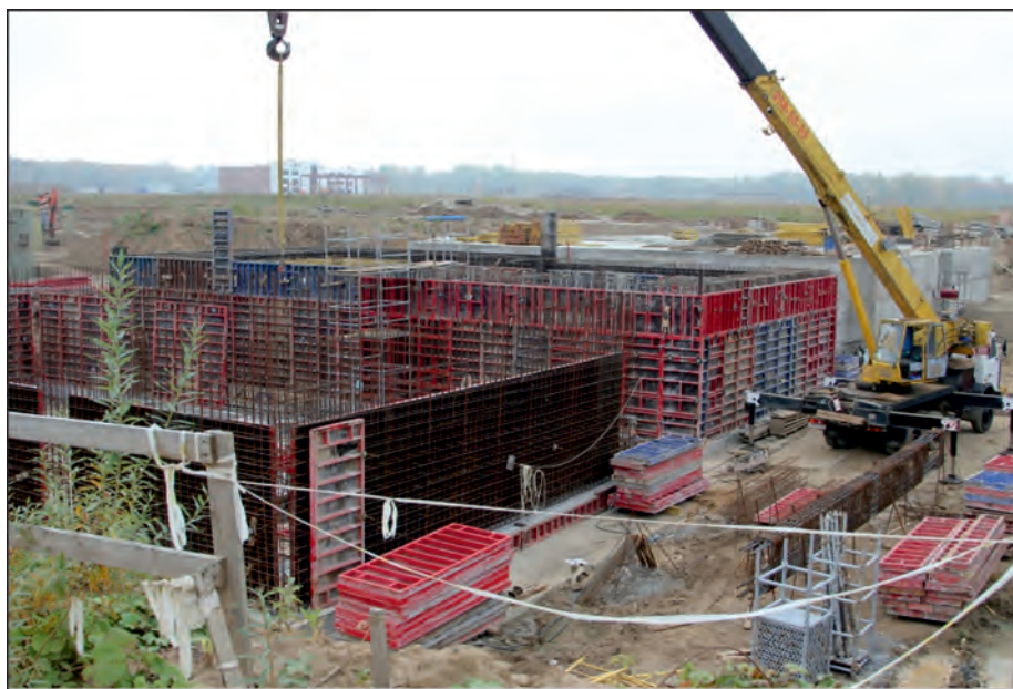
Рис. 3. Строительство опытно-демонстрационного комплекса на площадке Сибирского химкомбината
